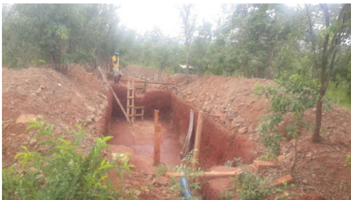
Das Kanalisationsprojekt wird in Angriff genommen. Alle Aushübe werden von Hand gegraben!
