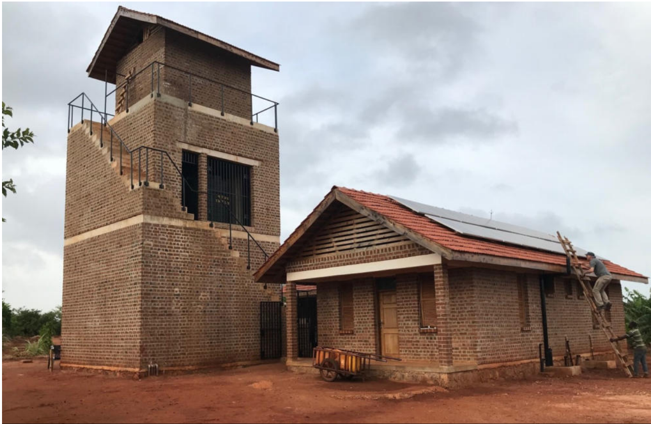
So sieht das Wasserprojekt fertig aus! Auch die PV-Anlage für die Solarpumpe ist zu sehen.
